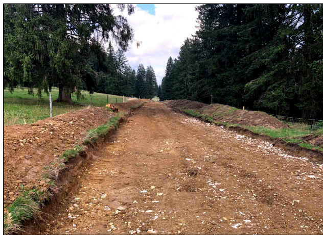
Schneise beim Windpark in Tramelan (BE), derzeit im Bau. (Bild Freie Landschaft Schweiz)
