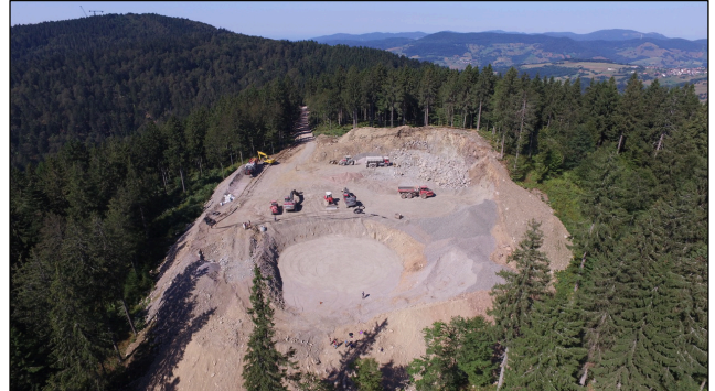
Windpark Gersbach im Schwarzwald (D), 2023 im Bau. (Bild Freie Landschaft Schweiz)
