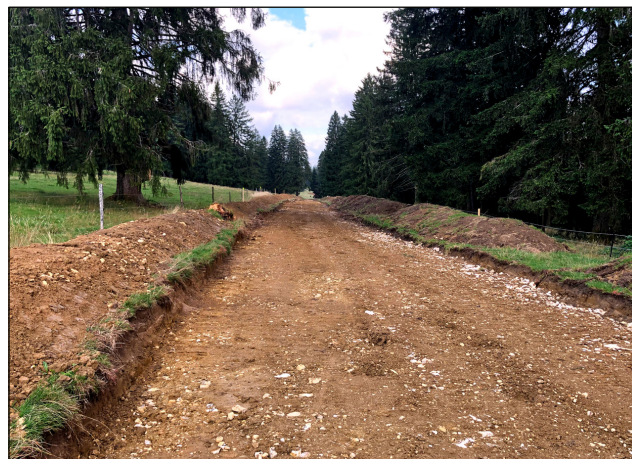
Allée près du parc éolien de Tramelan (BE), actuellement en construction. (Photo Paysage Libre Suisse)
